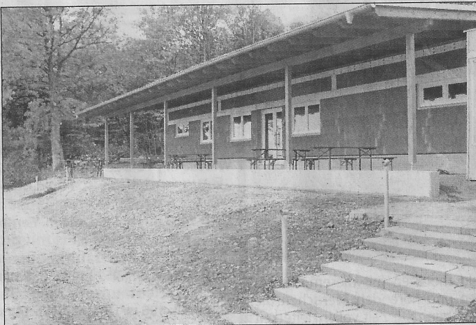
Das neue Vereinsheim des SC Dombach im Rohbau.
